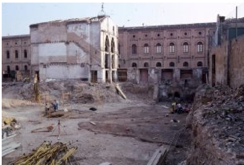
Figura 1. Vista general de la excavación, foto C. Aguarod.
